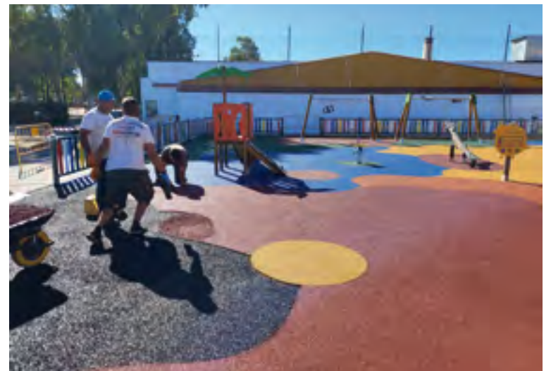
Trabajos de construcción de la zona infantil en el parque Carbonífera
